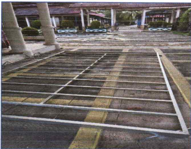
Gambar 3 : Tahapan pengerjaan mal tempat pemasangan videotron.
